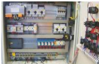
Schaltschrank / SPS-Steuerung
