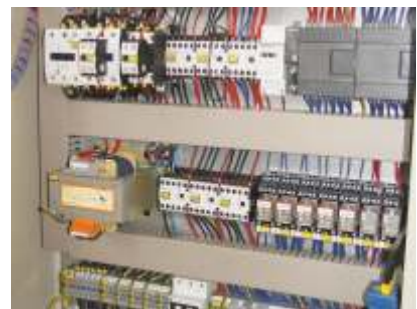
Schaltschrank / SPS-Steuerung
